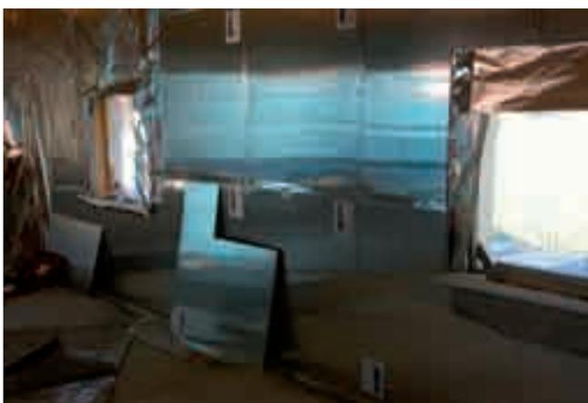
Figura 16. L'installazione dello strato di PCM.
