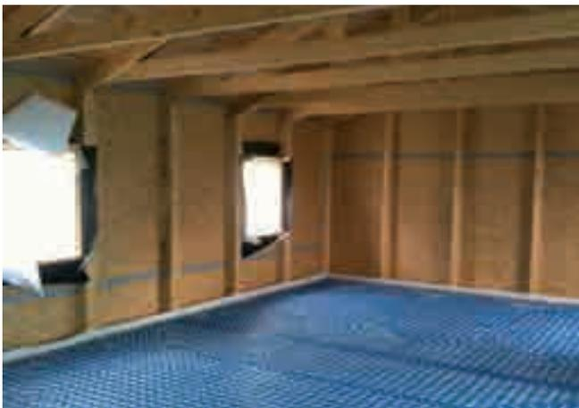
Figura 10. Le serpentine sottopavimento.
