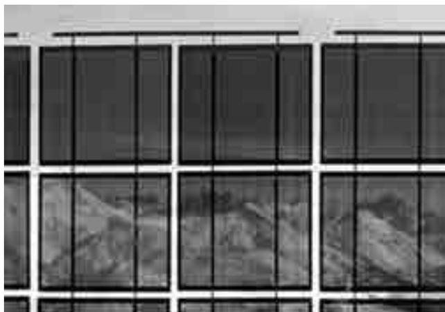
Figura 9. Moduli fotovoltaici semitrasparenti (Onyx Solar).
