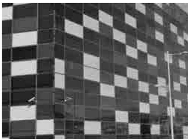
Figura 10. Facciata ventilata fotovoltaica (Onyx Solar).
