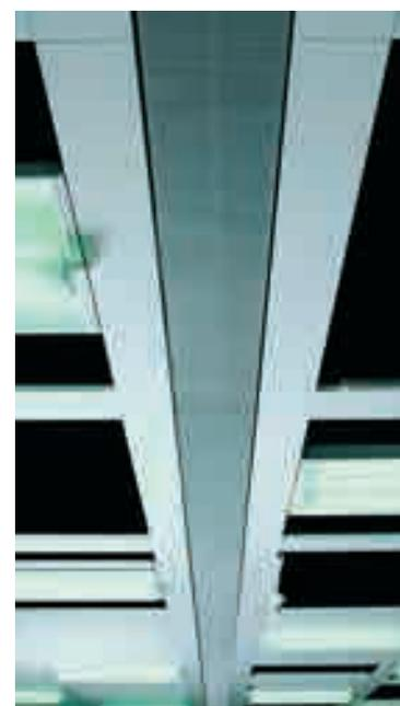
Figura 5. La disposizione delle travi fredde è modulare e segue il lay-out delle postazioni di lavoro.
